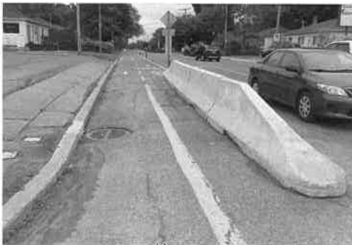
Figure 4-1 : Barrière en béton sur la piste cyclable de la 5 e Avenue
